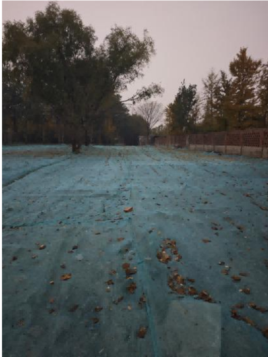
项目内土地平整情况
