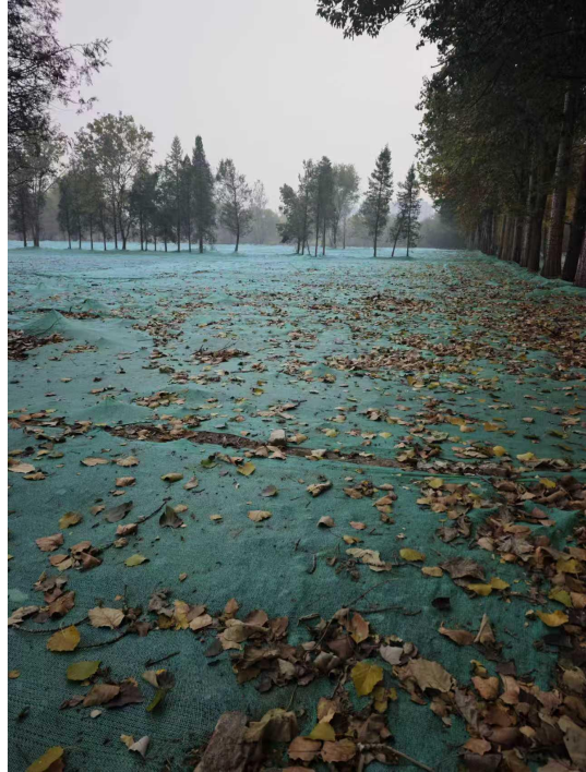
项目内土地平整情况
