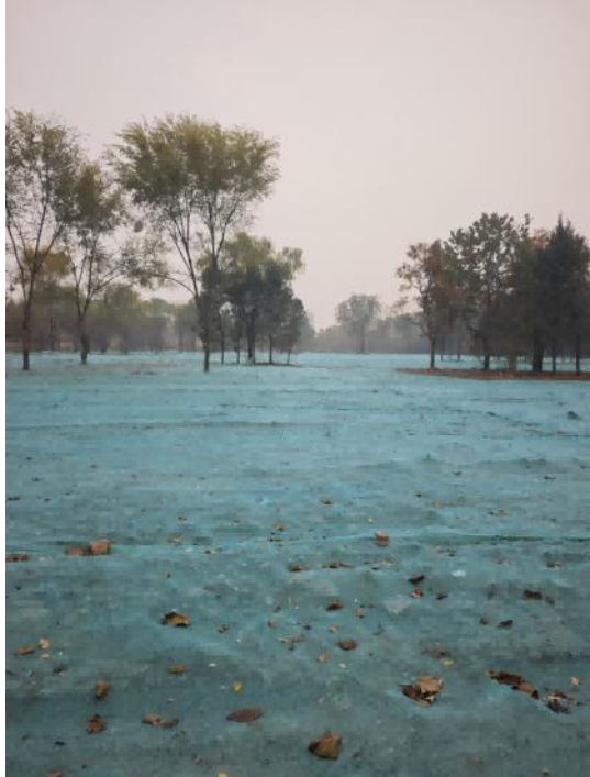
项目内土地平整情况
